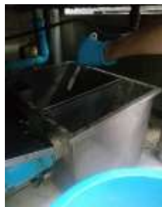
รูปที่ 2-18 การเก็บกวาดตักส่วนที่เป็นไขมันที่ลอยอยู่บริเวณผิวหน้าถังดักไขมันและนำไปกำจัด
