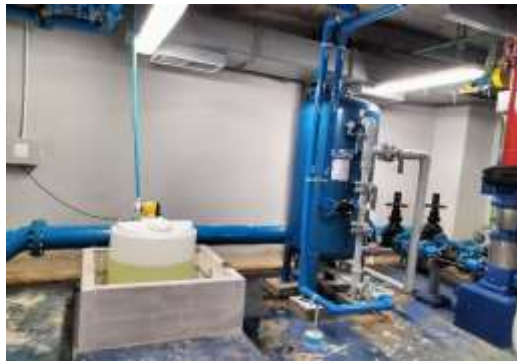
รูปที่ 2-12 การติดตั้งระบบกรองน้ำก่อนเข้าสู่ถังเก็บน้ำใช้และล้างถังสำรองน้ำปีละ 1 ครั้ง
