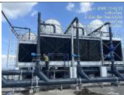
รูปที่ 2-43 ผนังล้อมรอบด้านข้างเหนืออ่างรองรับน้ำในห้องฝึ้งเย็น เพื่อลดการฟุ้งกระจายของละอองไอน้ำที่ปลิวออกมา
