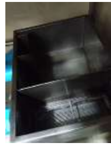
รูปที่ 2-18 การเก็บกวาดตักส่วนที่เป็นไขมันที่ลอยอยู่บริเวณผิวหน้าถังดักไขมันและนำไปกำจัด
