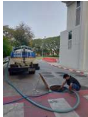
รูปที่ 2-13 การสูบน้ำออกบ่อบำบัดน้ำเสีย
