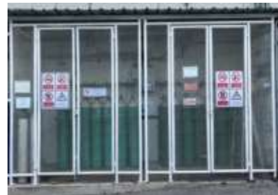
รูปที่ 2-44 พื้นที่จัดเก็บก๊าซ โครงการต้องพิจารณาจัดเก็บให้เหมาะสมตามประเภทของก๊าซที่บรรจุ
