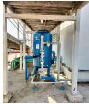
รูปที่ 2-12 การติดตั้งระบบกรองน้ำก่อนเข้าสู่ถังเก็บน้ำใช้และล้างถังสำรองน้ำปีละ 1 ครั้ง
