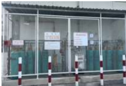
รูปที่ 2-44 พื้นที่จัดเก็บก๊าซ โครงการต้องพิจารณาจัดเก็บให้เหมาะสมตามประเภทของก๊าซที่บรรจุ
