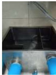
รูปที่ 2-18 การเก็บกวาดตักส่วนที่เป็นไขมันที่ลอยอยู่บริเวณผิวหน้าถังดักไขมันและนำไปกำจัด
