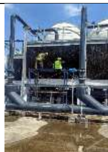
รูปที่ 2-43 ผนังล้อมรอบด้านข้างเหนืออ่างรองรับน้ำในห้องฝึ้งเย็น เพื่อลดการฟุ้งกระจายของละอองไอน้ำที่ปลิวออกมา
